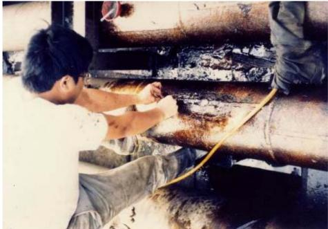
Abdichtung von Ölleitungen mit MM-metall oL-StahlKeramik. Ursache des Schadens waren undichte Schweißnähte.
