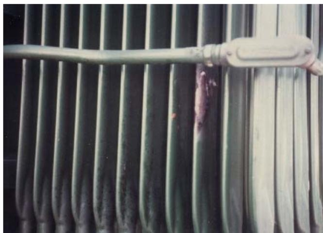
Abdichtung von Ölleckagen an Großtransformatoren mit MM-metall oL-StahlKeramik und Härter rot.
